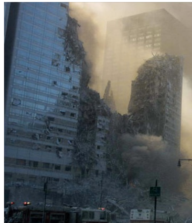
WTC 3 entre les deux effondrements
