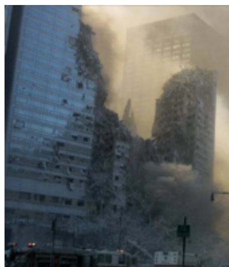
La tour 3 du World Trade Center, très endommagée et pourtant toujours debout.
